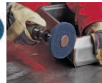
Зачистка стыкового сварного шва
