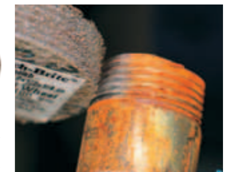
Очистка резьбы от ржавчины
