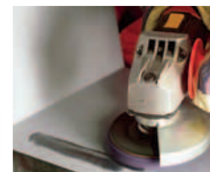
Удаление старого покрытия
