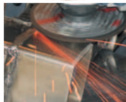
Удаление сварного шва
